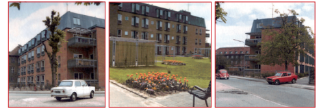
Den nybyggede Sydfløj, 1969.
